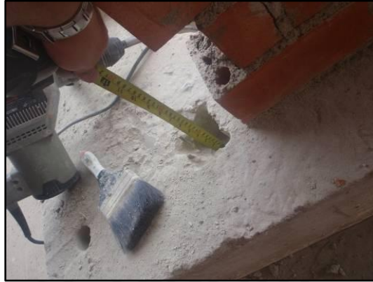
Figura 5.7. Huecos que se realizaron para anclar los refuerzos de \frac{1}{4} ".
