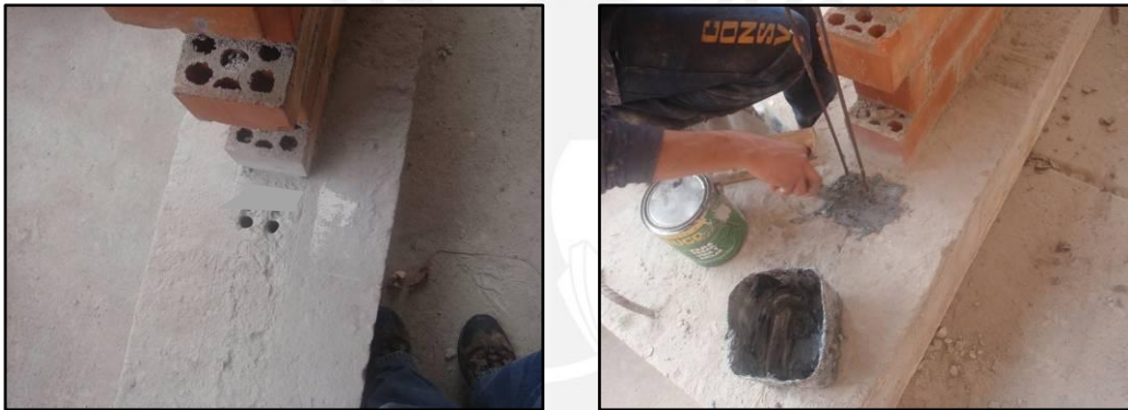
Figura 3.6. Perforaciones limpias y anclaje de varillas con Euco #452 Gel
