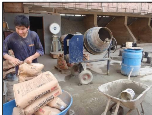
Figura 3.1. Elaboración del concreto.
