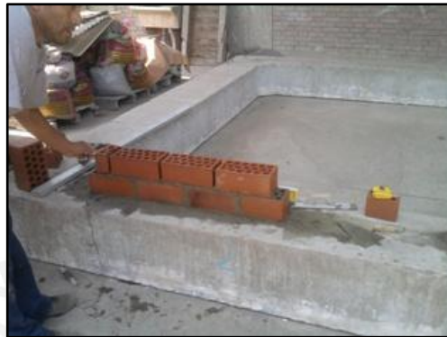
Figura 3.2. Colocación de mortero entre las unidades de albañilería en aparejo de sogá.
