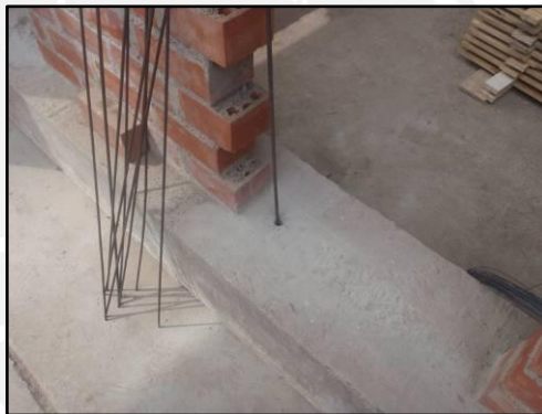
Figura 5.3. Conexión dentada albañilería – columna.
