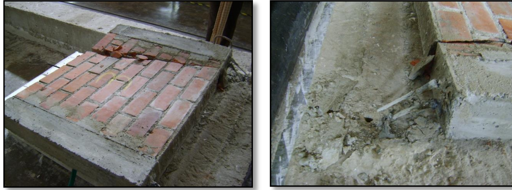
Figura 6.6 M4-Fase3 (Falla por anclaje del Refuerzo Vertical)
