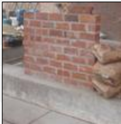
Figura 5.6. Parapeto M2 sin arriostres verticales.
