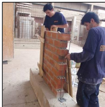
Figura 3.3. Colocación de estribos tipo gancho.
