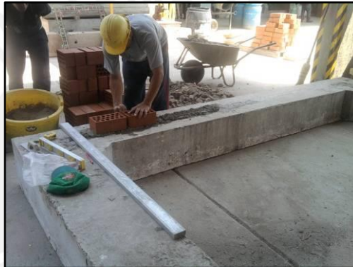
Figura 5.1. Construcción de la primera hilada.
