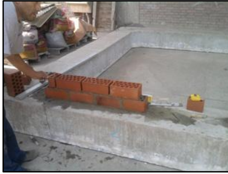
Figura 5.2. Construcción de la segunda hilada.
