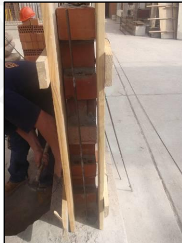
Figura 5.5. Encofrado de columneta con el refuerzo de 8mm.
