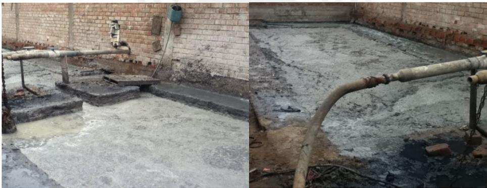
**Figura 31** – Pozas de sedimentación donde se recogen los efluentes de la empresa industrial antes de ser vertidos al alcantarillado
