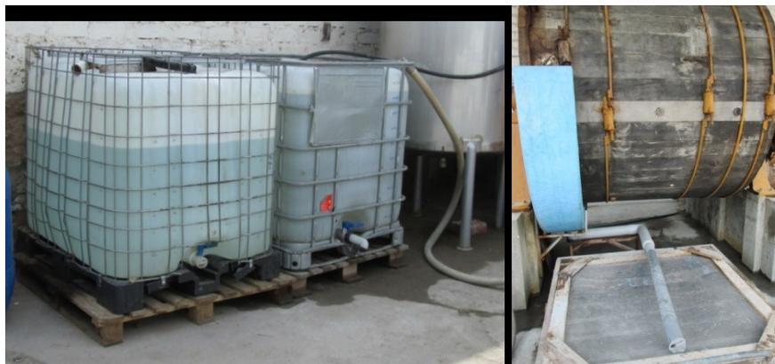
**Figura 43** – Contenedores donde se almacenan los efluentes de curtido (izquierda) y malla usada para filtrar dichos efluentes (derecha)
