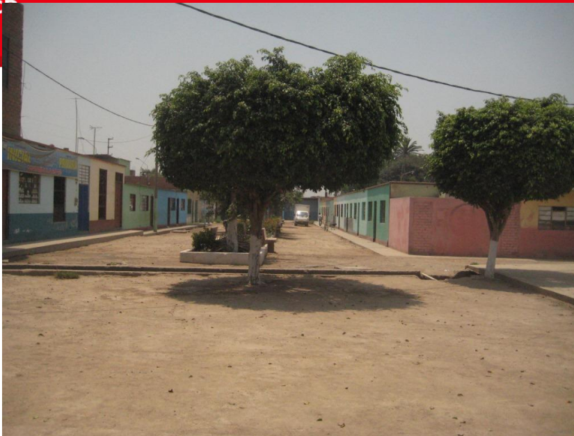
Figura 12: Calle principal del centro poblado de La Molina, conocida como Ranchería. Nótese el estado de la calle, sin asfaltar.
