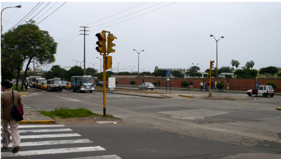
Fig. 6.11 Dispositivos de control de tráfico en la intersección
