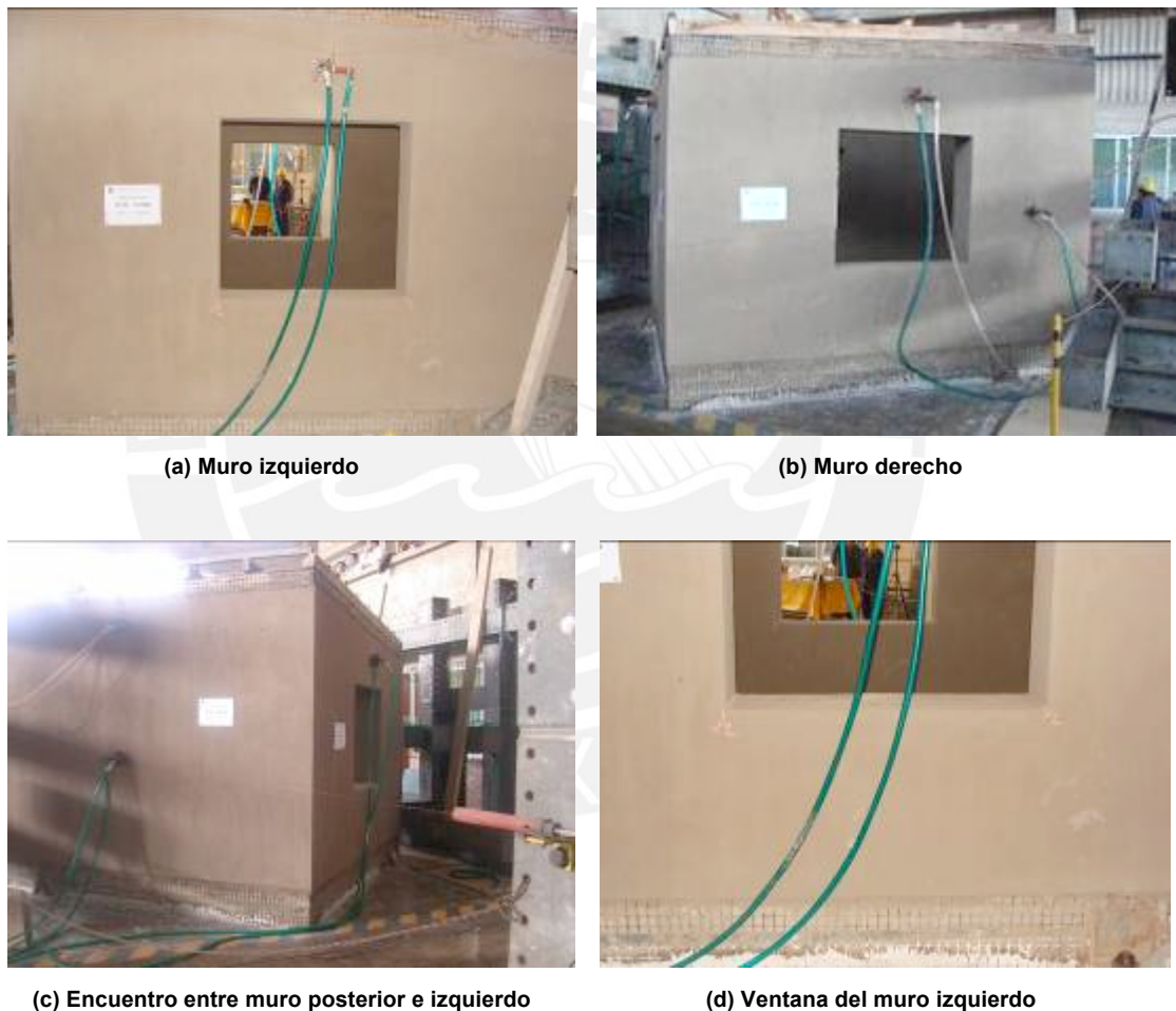
Figura 8.5 Daños en el módulo M100-T4100D – Post Fase 2 (80mm)
