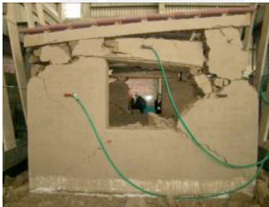
(c) Muro derecho
