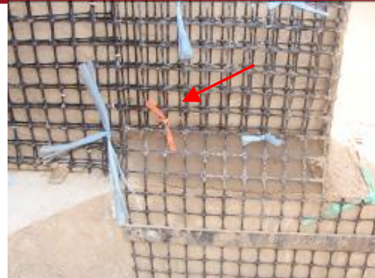
Figura 10.2. Amarre de traslapes colocando puntos de rafia adicionales
