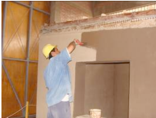
Figura 3.28. Sello de fisuras con brocha
