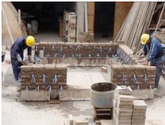
Figura 3.16 Asentado de adobes
