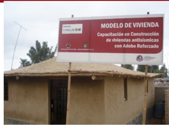
Figura 1.6. Vivienda construida de adobe reforzado (Fuente: DARS)
