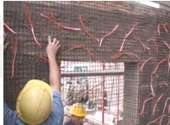
Figura 3.21. Colocación y amarre del paño de geomalla
