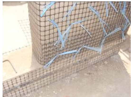
Figura 3.23. Amarre y traslape de la geomalla de refuerzo con la geomalla de cimentación
