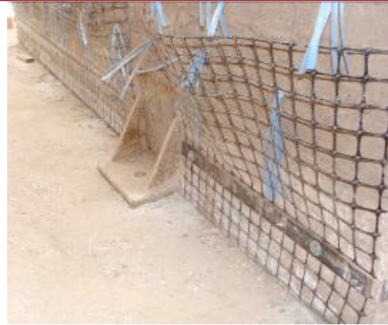
Figura 3.11. Fijación de la geomalla de cimentación en el módulo
