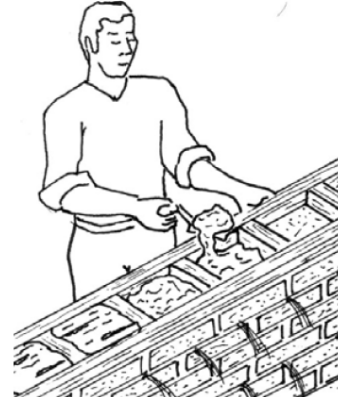
Figura 3.19. Colocación de barro en la viga collar (Fuente: Vargas et al, 2007)
