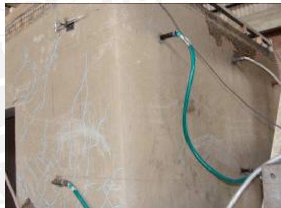
(d) Encuentro entre el muro derecho y posterior
