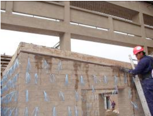
Figura 3.20. Embarrado de la viga collar
