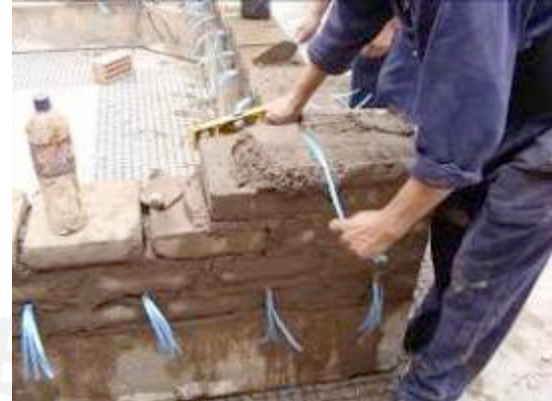
Figura 3.15. Colocación de rafia
