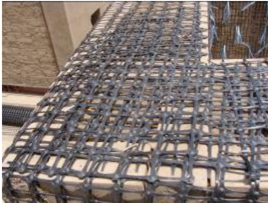
Figura 3.24. Fijación de la geomalla sobre la viga collar
