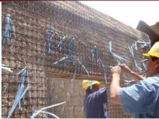
Figura 10.1. Amarre de traslapes con la rafia ya colocada
