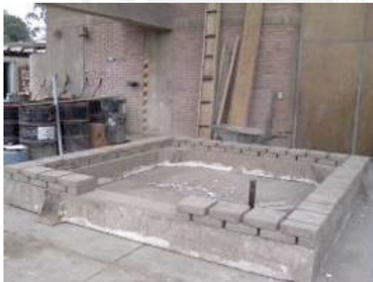
Figura 3.12. Emplantillado de adobes
