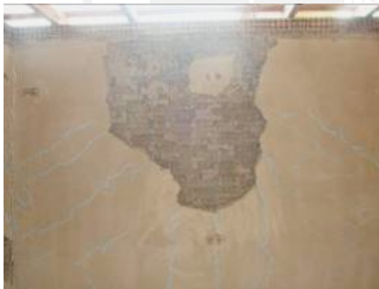
(c) Muro posterior (interior)
