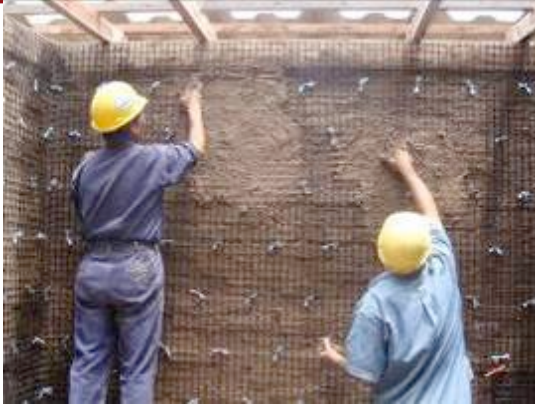
Figura 3.26 Primera capa de tarrajeo
