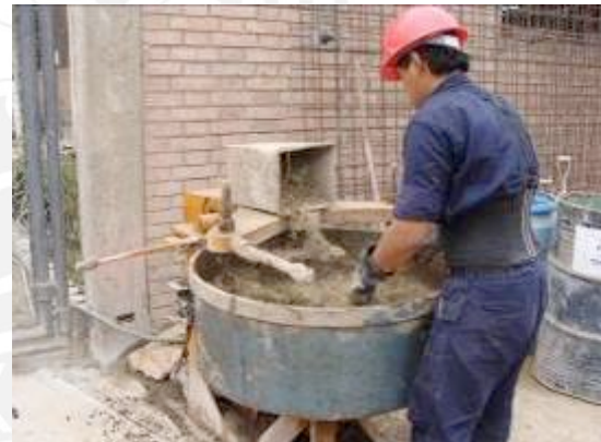
Figura 3.13. Preparación del mortero de barro
