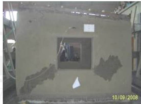
(b) Muro izquierdo (exterior)
