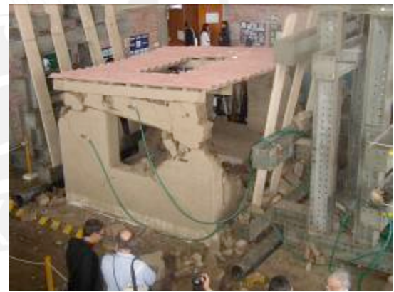
(d) Encuentro entre muro derecho y posterior
