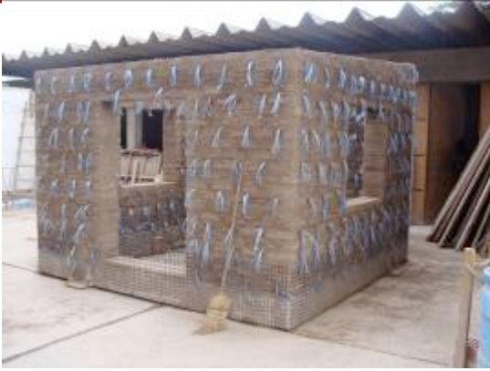
Figura 3.18. Muros del módulo terminados
