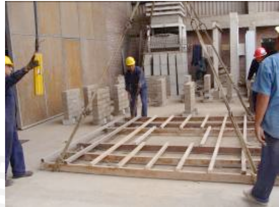
Figura 3.25. Colocación del techo
