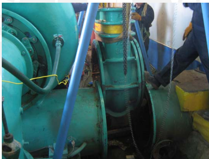
S6. Desmontaje de la antigua válvula de admisión [Material propio]
