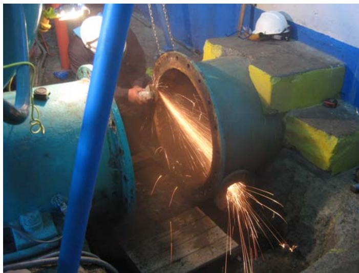
S7. Limpieza de las bridas de la tubería forzada y del caracol de la turbina [Material propio]
