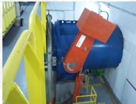
Figura 1.5. Válvula de admisión tipo mariposa de la central Chimay (Material propio)
