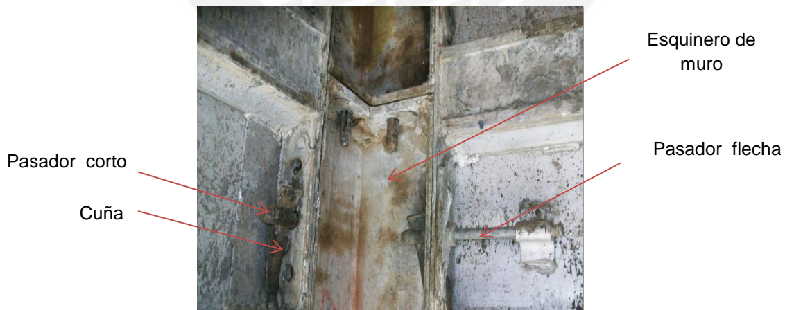
Figura 5.6. Elementos de encofrado (2 – 3)
