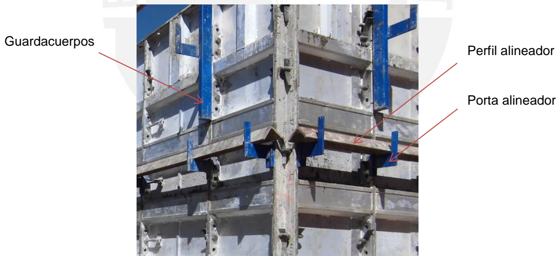
Figura 5.7. Elementos de encofrado (3 – 3)
