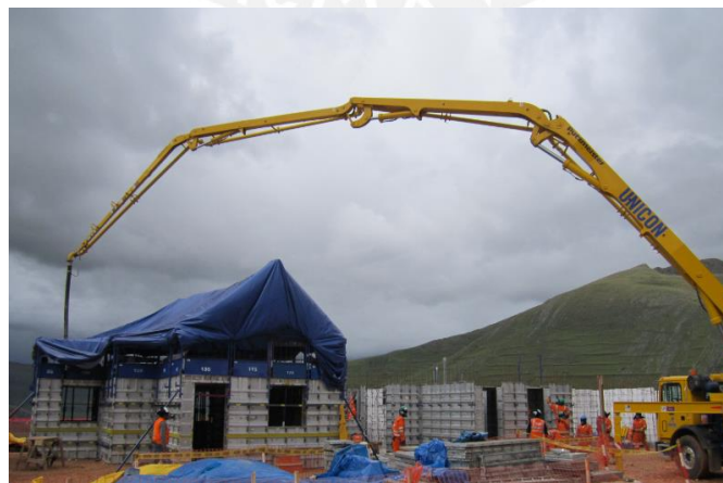
Figura 5.9. Vaciado mediante bomba de muros y losas del primer nivel de una vivienda con carpa instalada
