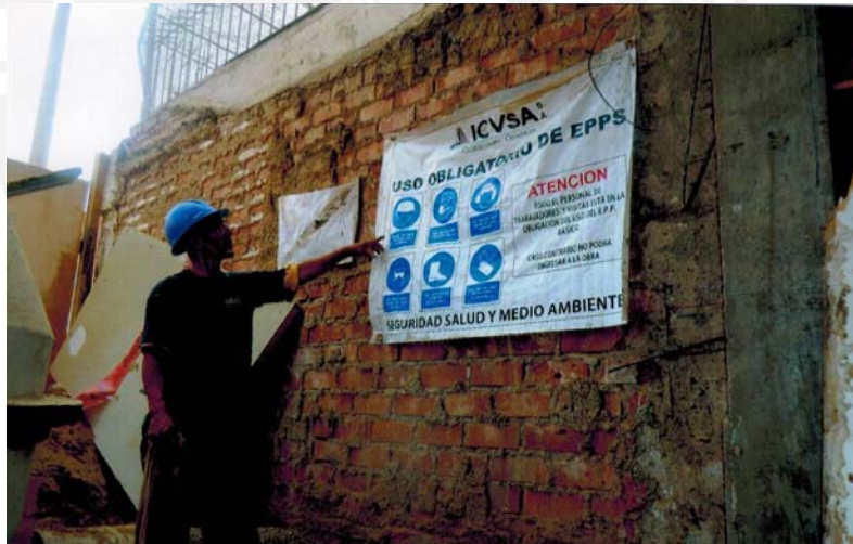
Figura 2: Operando indicando las Normas de Seguridad
