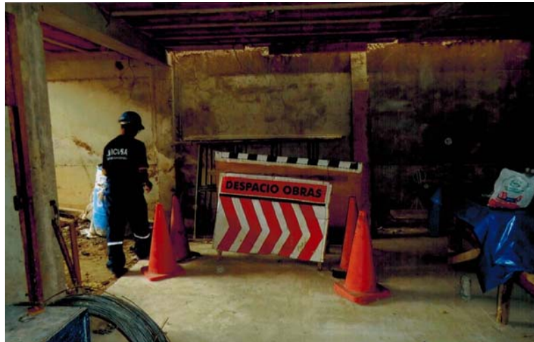
Figura 1: Señalizaciones de Seguridad dentro de la Obra
