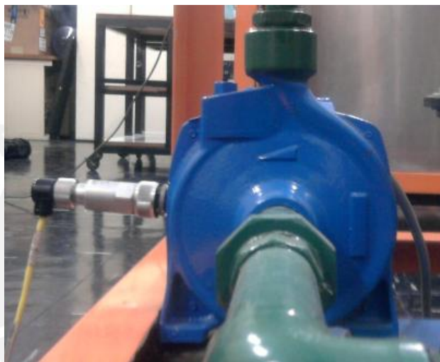
Fig. 4.10 Montaje del Acelerómetro en la Bomba Centrífuga
