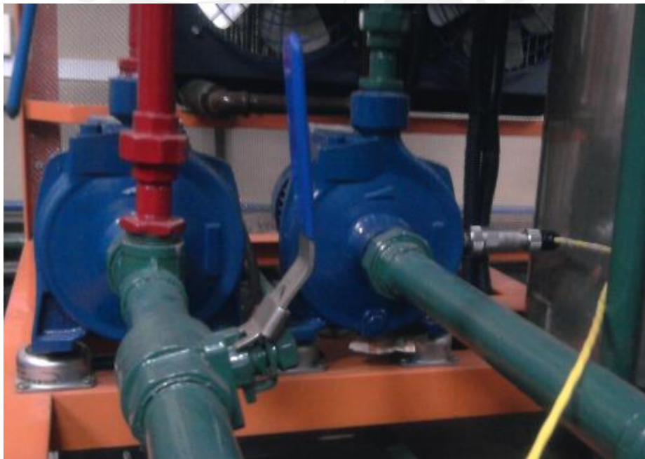
Fig. 4.13 Montaje del Acelerómetro en la Bomba Centrífuga
