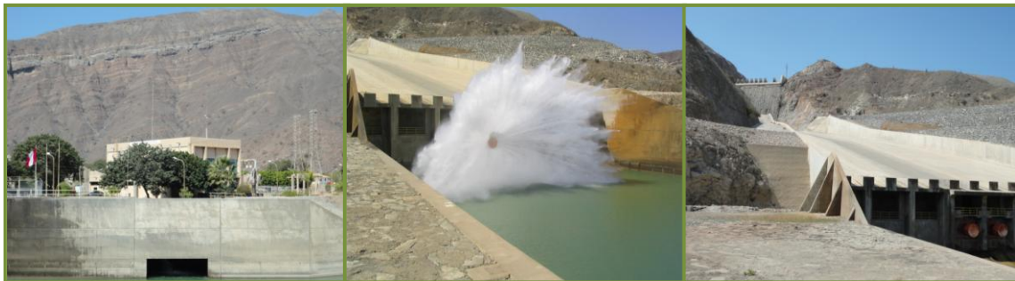
Figura 6. Central hidroeléctrica Gallito Ciego (izquierda). Válvulas Howel Bungger en operación (centro). Aliviadero de represa (derecha). Fuente: Fotografías del proyecto DGI PUCP 70245.0110
