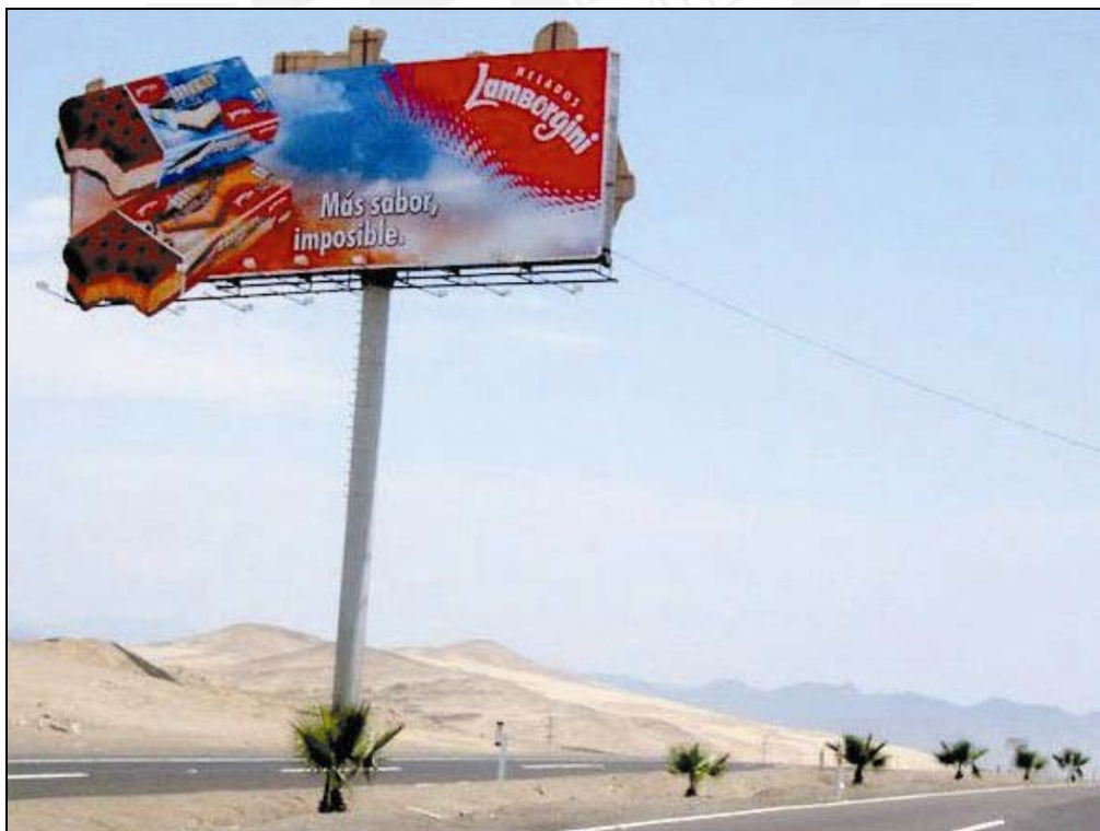
Panel carretero (torre unipolar) de la marca de helados Lamborghini, con sistema de iluminación artificial Panamericana Sur (Verano 2004)
