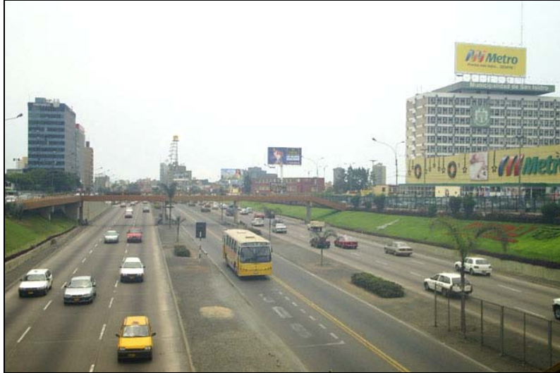
Vista panorámica de los alrededores al Centro Bancario en San Isidro
