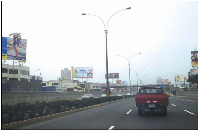
Vista panorámica de la Vía Expresa de Javier Prado (2005)
