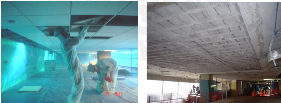
Figura 34. Remoción Asbesto en el Salón Principal
