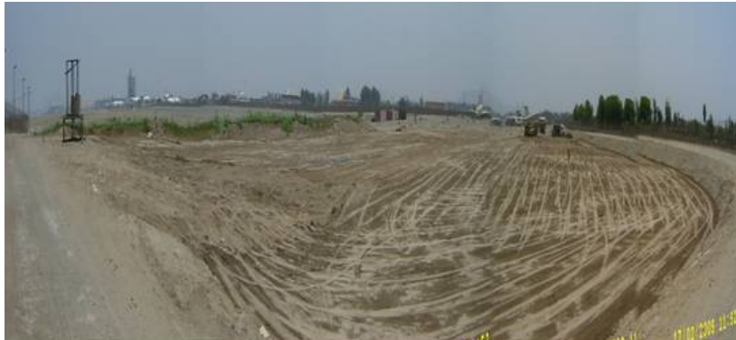
Figura 38. Terreno nivelado luego de la remediación
