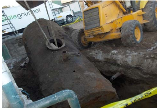
Figura 32. Remoción de Tanque de Combustible
