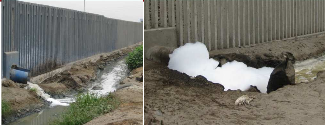
Figura 41: Efluentes de la PTAR
