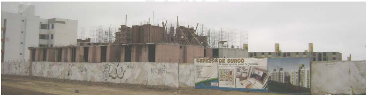
Fotografía 14: Al lado de la 'Cruceta' se encuentran construyendo más condominios.
