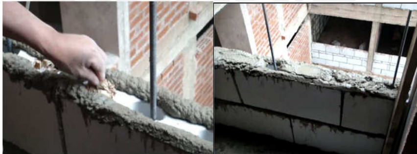
Figura 5.26. Relleno de alveolos con papel seco y relleno de juntas horizontales con grout.
