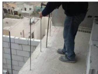
Figura 5.54. Anclaje de refuerzo vertical
