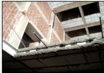
Figura 5.29. Grout en ancho efectivo de la tercera hilada.
