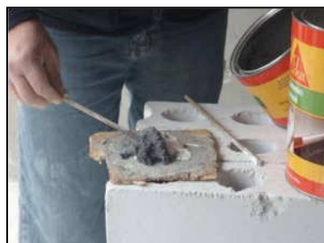
Figura 5.4. Preparación de epóxico.
