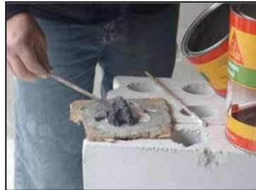
Figura 5.52. Preparación de epóxico.
