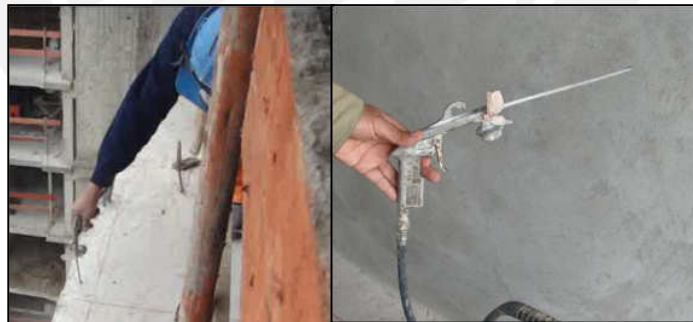
Figura 5.35. Limpieza de agujeros de anclaje con compresora de aire de murete M3.
