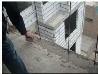
Figura 5.55. Aplicación de agua para humedecer superficie de concreto.
