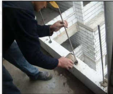
Figura 5.42. Colocación de grout en alveolos.
