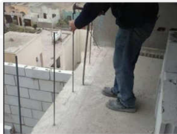
Figura 5.6. Anclaje de refuerzo vertical.
