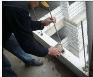
Figura 5.58. Colocación de grout en alveolos.
