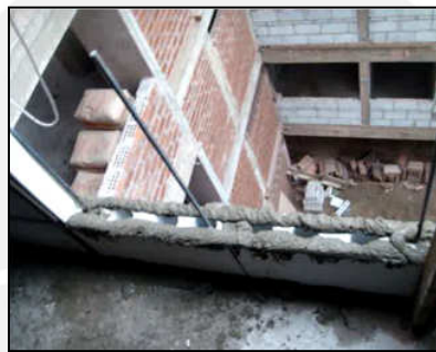
Figura 5.22. Colocación del grout sólo en el espesor efectivo del murete.
