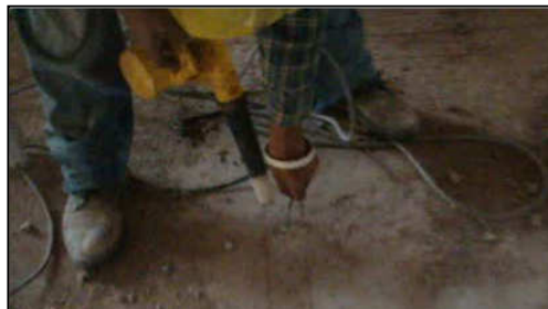
Figura 5.18. Limpieza de perforaciones para el anclaje del murete M2.
