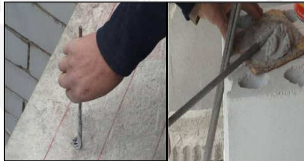
Figura 5.53. Aplicación de epóxico en agujeros de la Placa P10 y en el refuerzo vertical.
