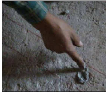
Figura 5.19. Aplicación de epóxico con el dedo en las perforaciones.
