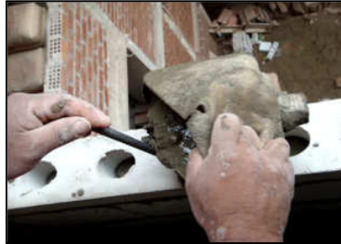
Figura 5.28. Llenado de alveolos con grout utilizando una vara de acero.
