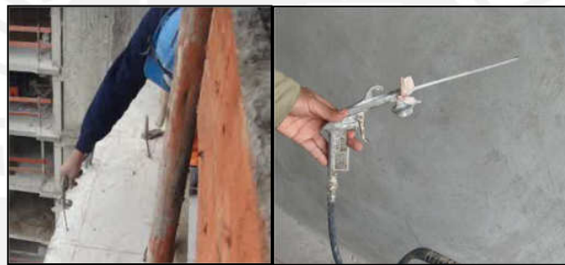
Figura 5.3. Limpieza de agujeros de anclaje con compresora de aire.
