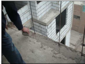
Figura 5.39. Aplicación de agua para humedecer superficie de concreto.
