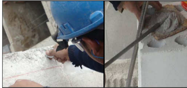
Figura 5.5. Aplicación de epóxico en agujeros de la Placa P10 y en el refuerzo vertical.
