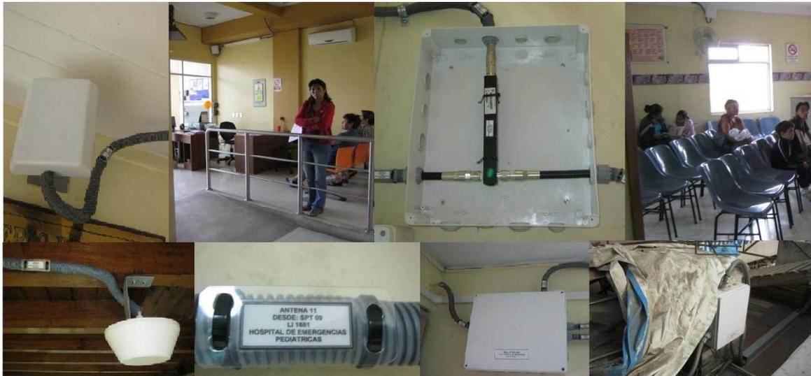
**FIGURA 3-9: ANTENAS Y SPLITTERS AL INTERIOR DEL HOSPITAL.**
