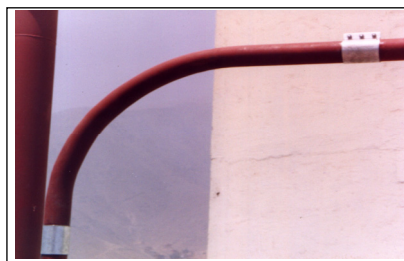
Fig. 1.12 Codo de radio largo con acoplamiento rápido.
