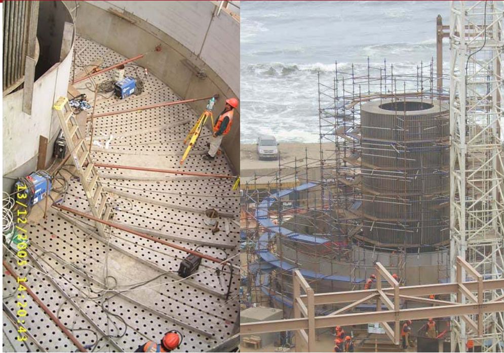
Figura 11: La soldadura en espacios de acceso limitado y en altura hacen necesario una selección adecuada de equipamiento que permita ejecutar los procedimientos de soldadura propuestos en cada lugar requerido. Por eso material de aporte, procedimientos, equipos, plan de inspección, etc. forman parte de una solución completa a un problema de soldadura.
