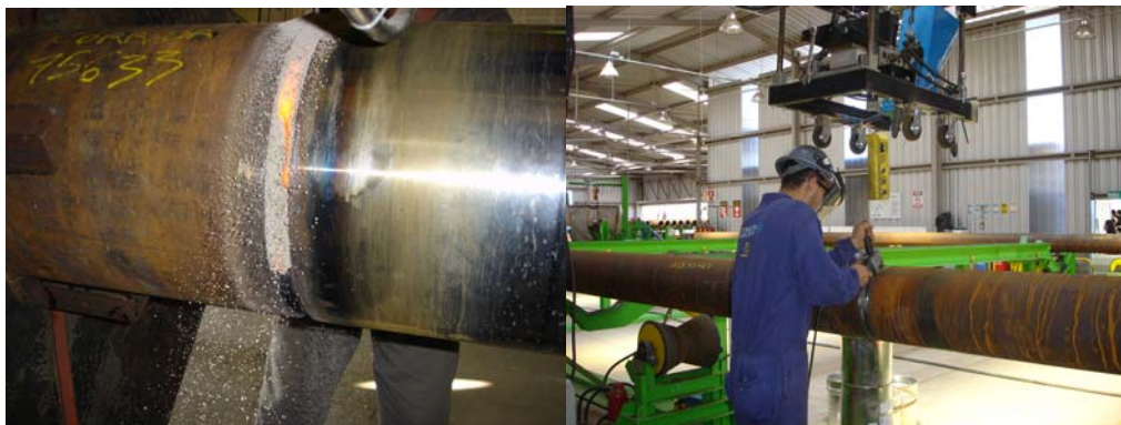
Figura 22: SAW para el relleno y acabado girando sobre rodillos viradores “turning rolls” para el shop welding (Bira Costa Millerwelds Brasil).
