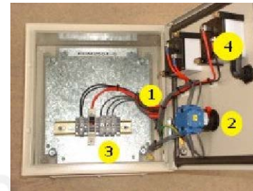
Figura 4.6 Controlador y Rectificador con Amperímetro y Voltímetro del Aerogenerador Proven
