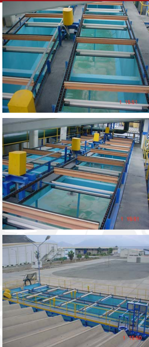
Fig. 5.3. Vistas de una Trampa de Grasa
