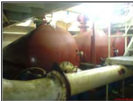
Tubería de HDPE de 18" de diámetro
