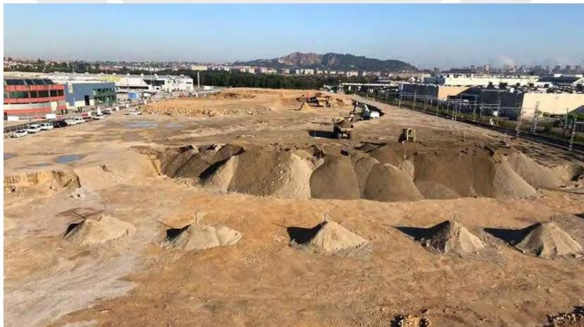
Figura 2.6. Método de precarga para terraplenes (Terratest, 2019).
