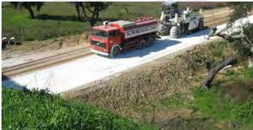
Figura 2.7. Estabilización de suelos con cal (Probisa, 2020).
