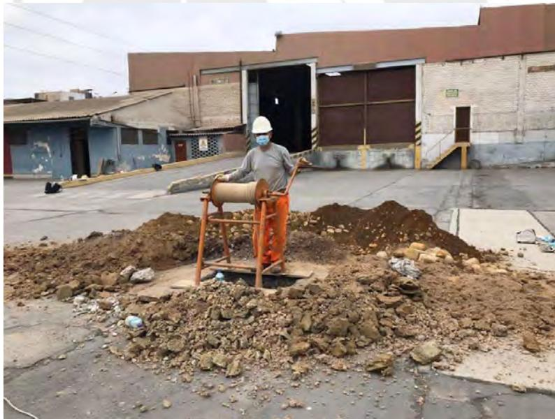
Figura 3.1. Extracción de muestra mediante calicatas en Callao.
