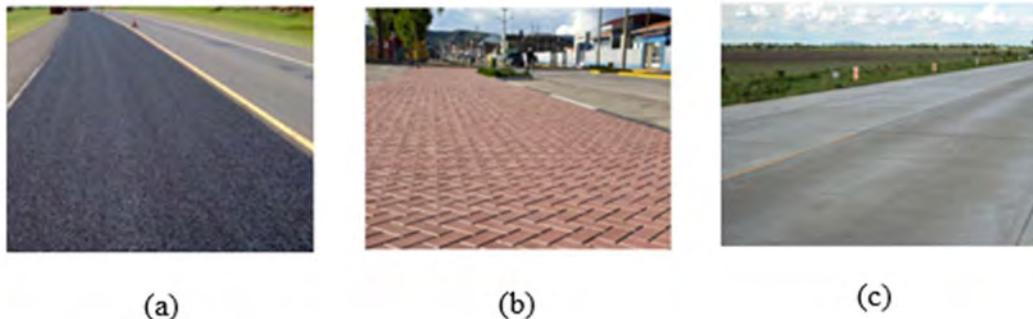
Figura 2.1. (a) Pavimentos flexible, (b) semirrígido y (c) rígido.
