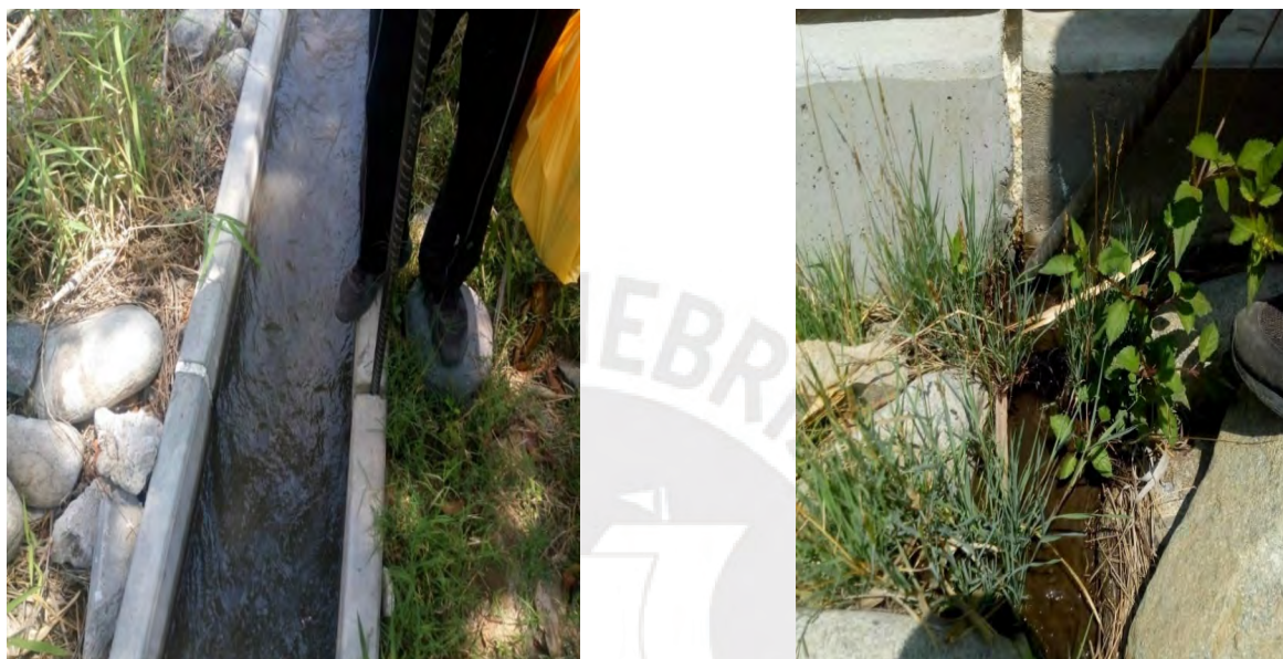
Figura 70 y 71. Juntas del canal Wich Wich.
