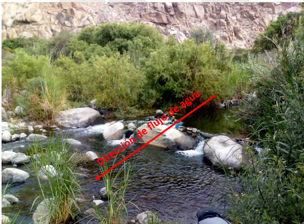
Figura 15. Imagen del enrocado para desviar agua al canal Wich Wich en época de lluvias.
