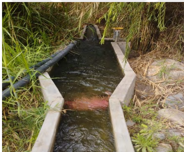
Figura 59. Desarenador existente.
