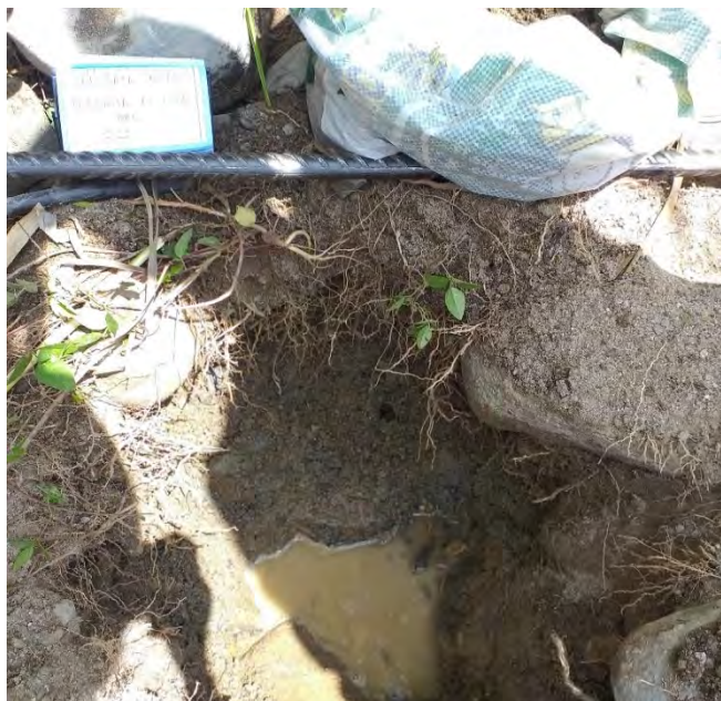
Figura 18. Imagen de la calicata N° 2 ubicada a la proyección de la entrada del encauzamiento. (fuente propia). (Perú), 2022.
