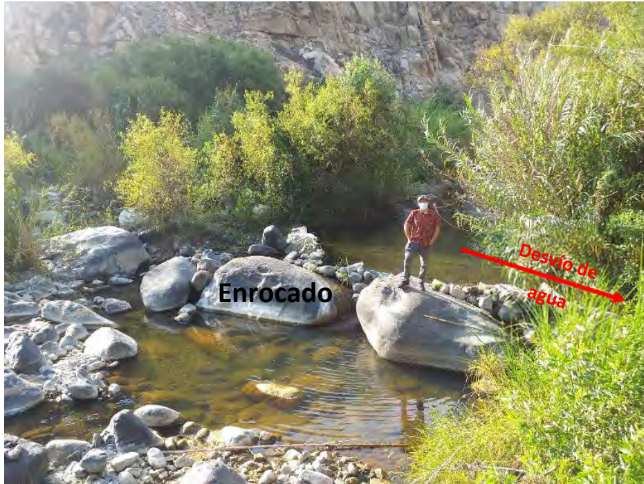
Figura 16. Imagen del enrocado para desviar agua al canal Wich Wich en época de sequía. (fuente propia). (Perú), 2022.
