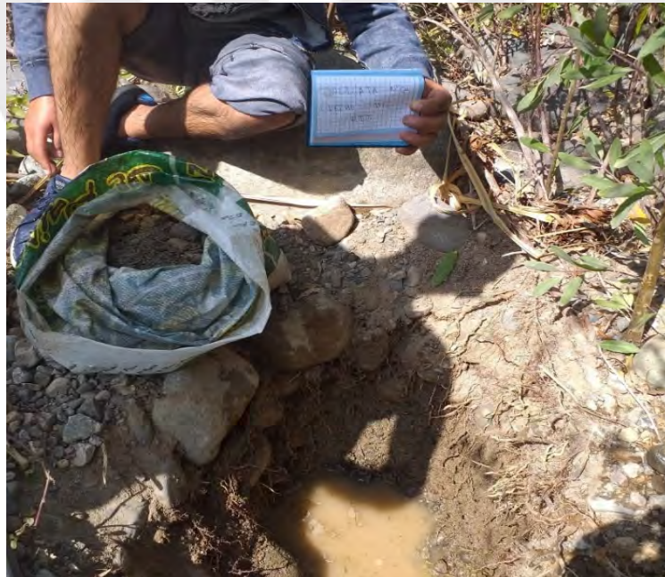
Figura 17. Imagen de la calicata N° 1 ubicada a la proyección del lugar de la toma. (fuente propia). (Perú), 2022.
