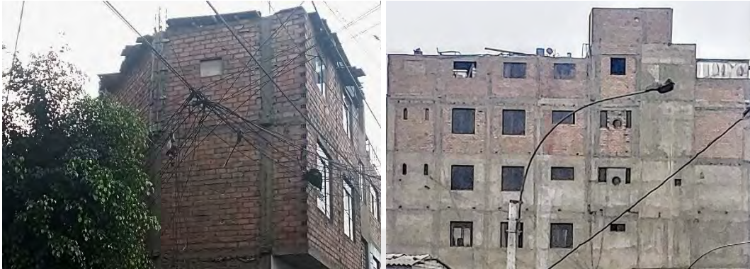
Figura 1: Edificaciones con aberturas en muros de albañilería.
