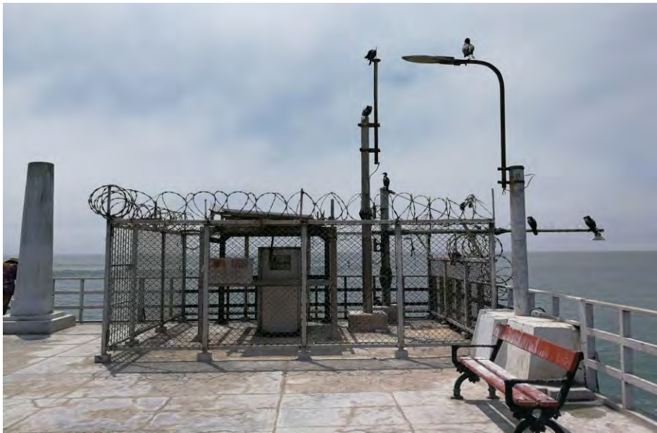
Figura 5.1.10 Mareógrafo instalado en el muelle de Cerro Azul
