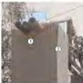
Columna de concreto y cercha de caña de Guayaquil, expuesta al desgaste, no tratada.
