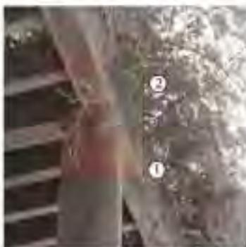
Madera tratada, pintada. Uso de planchas metálicas en conexión columna, viga. Follaje como cubierta translúcida.
