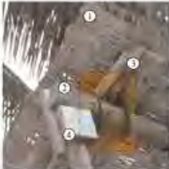
Uso frecuente de madera rolliza, expuesta al desgaste, no tratada.
