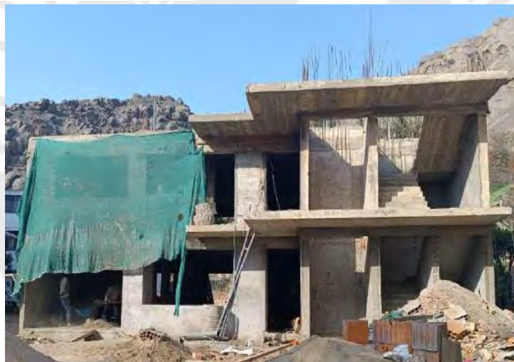
Figura 14. Proyecto multifamiliar en ejecución Fuente: Elaboración Propia.
