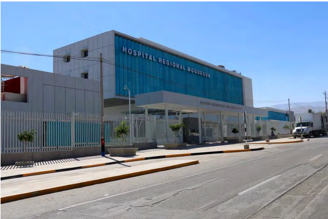
Figura 5.1 Fachada Hospital Regional de Moquegua (Imagen MINSA)
