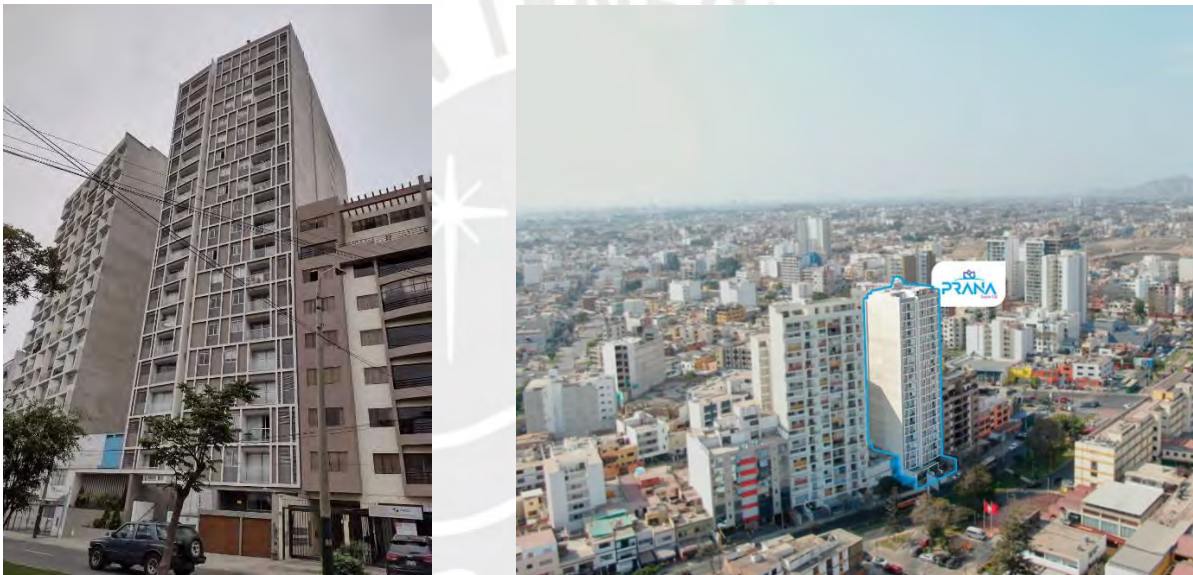
Gráfico 8. Edificio Prana y su ubicación en el perfil urbano. Fuente: Izquierda, fotografía propia. Derecha, imagen obtenida de COSAPI.
