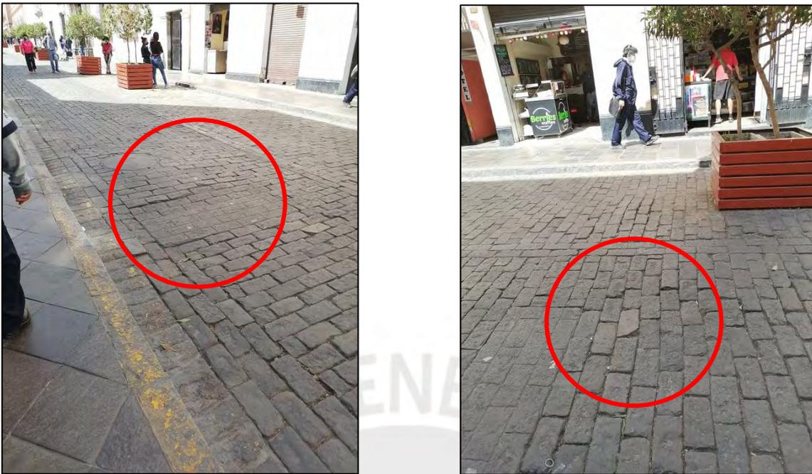
Figura 8 Desnivel en las calles debido a los adoquines
