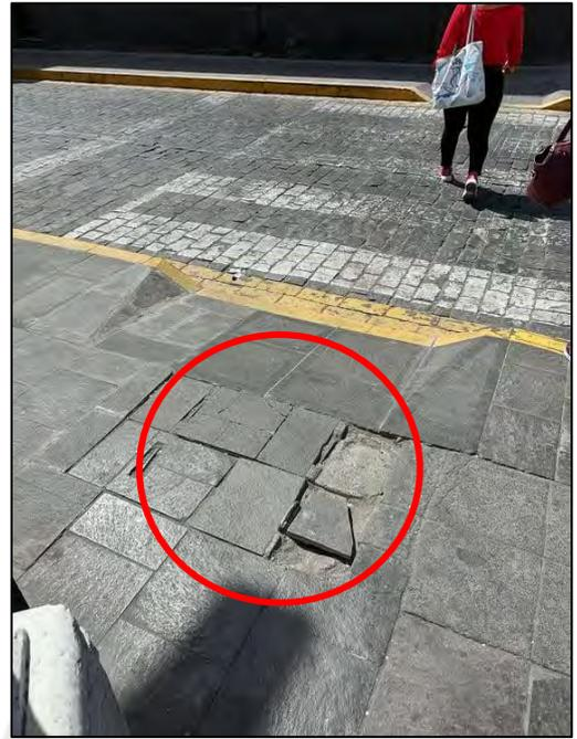
*Figura 3* Rampas de los cruces peatonales en mal estado
