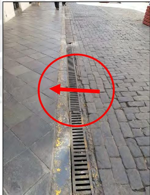
*Figura 6* Rejillas paralelas al movimiento o con ancho inadecuado
