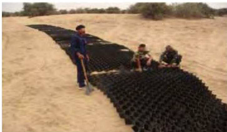
Figura 2.2: Colocación de la geocelda de un tramo de 30 m (Chatterjee et al., 2020).
