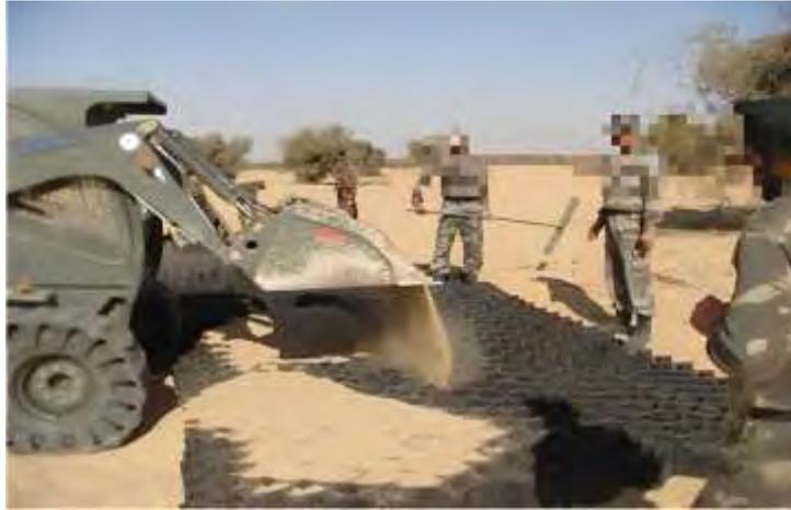
Figura 2.3: Colocación del relleno sobre la geocelda (Chatterjee et al., 2020).
