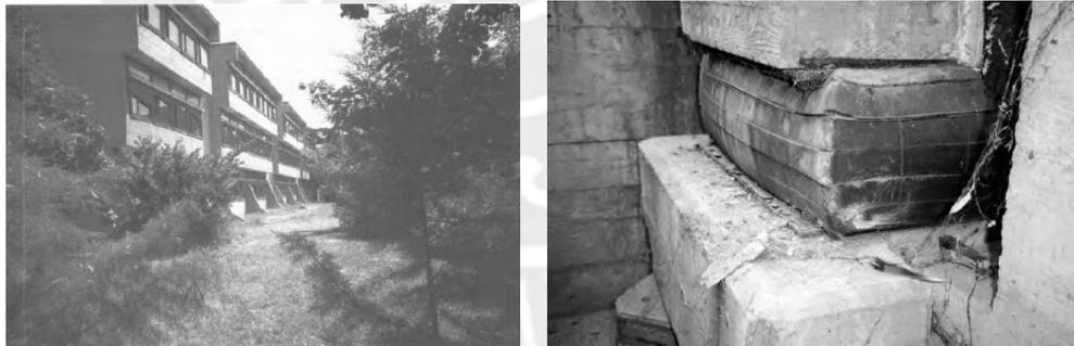
Figura 2. Escuela Pestalozzi en 1969 (Izquierda) y Aisladores de caucho natural usados en ella (Derecha). Tomado de Naeim & Kelly, 1999.
