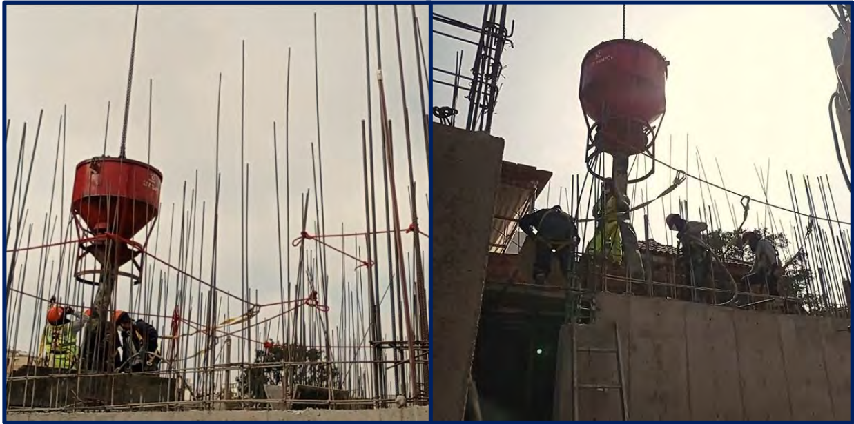
Gráfico 10. Vaciado de concreto en muros en obra.
