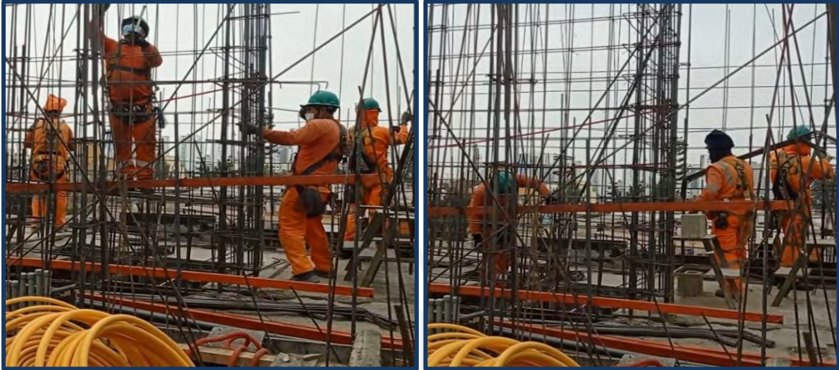
Gráfico 8. Armado de acero de muros en obra.
