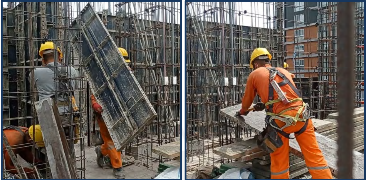
Gráfico 9. Colocación de encofrado de muros en obra.
