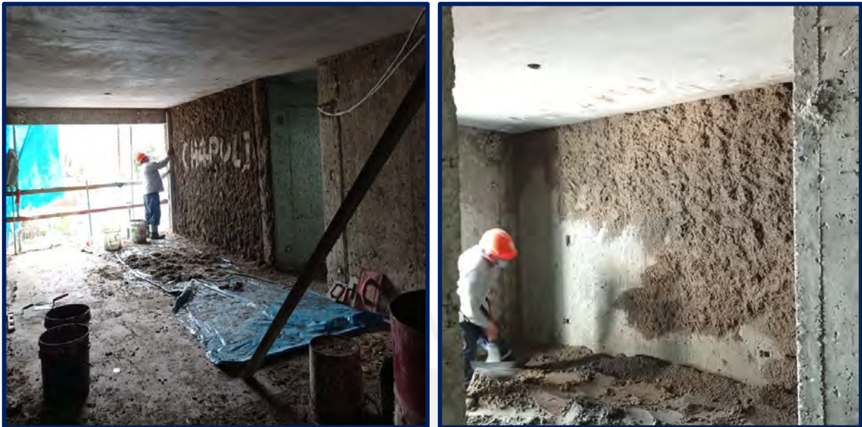
Gráfico 11. Tarrajeo de muros en obra.
