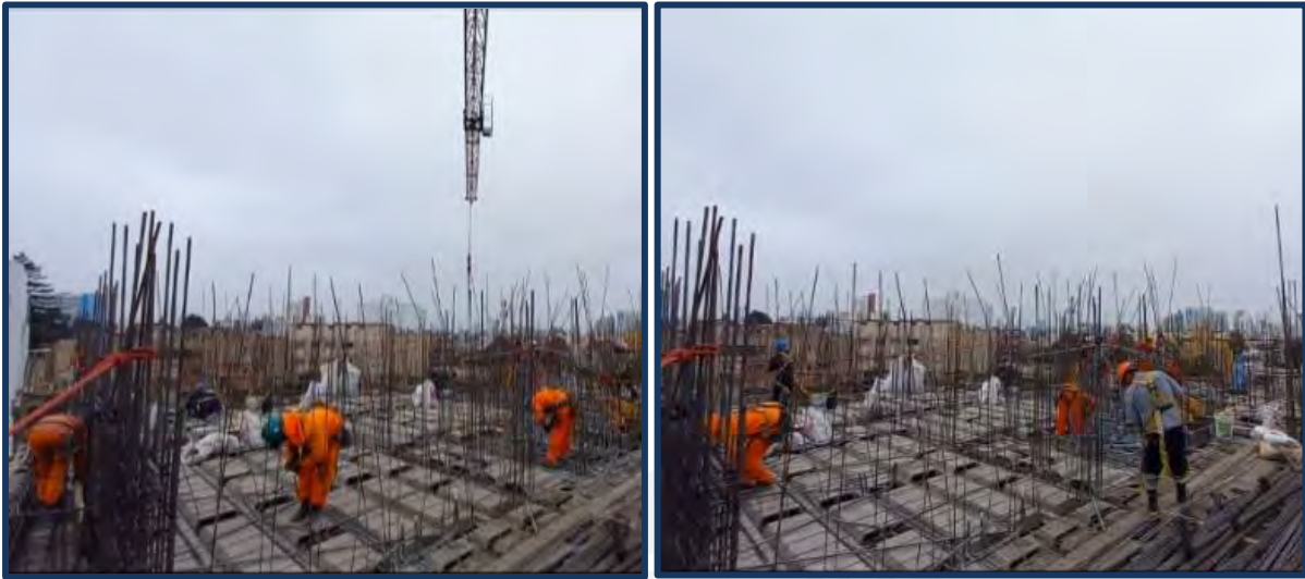
Gráfico 13. Armado de acero de losas en obra.
