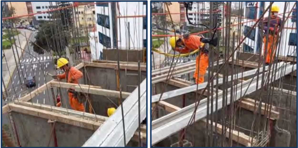
Gráfico 12. Colocación de encofrado de losas en obra.
