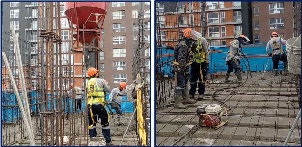
Gráfico 14. Vaciado de concreto en muros en obra.
