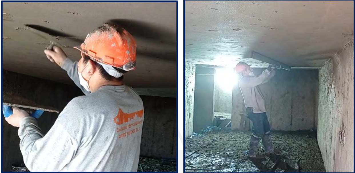
Gráfico 15. Tarrajeo de muros en obra.
