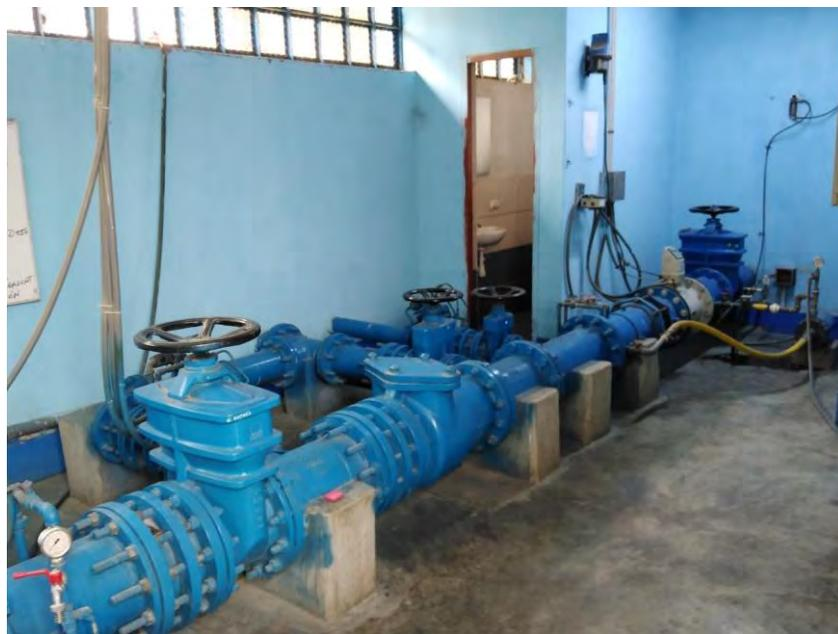
Figura 36. Tubería de conducción y bomba de cloro. Obtenida de la visita a Sedapal en el marco del Proyecto PI0841.
