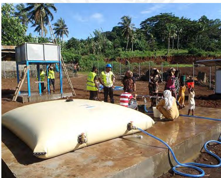
*Figura 12.* Tanque flexible para el almacenamiento de agua potable. Obtenido de PRONAL (PRONAL, 2024)
