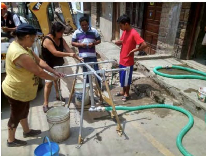
Figura 13. Aplicación de sistema “vaquita” para la óptima distribución de agua. Recuperado de la Guía práctica de agua, saneamiento y promoción de la higiene en emergencias (PREDES, 2017).
