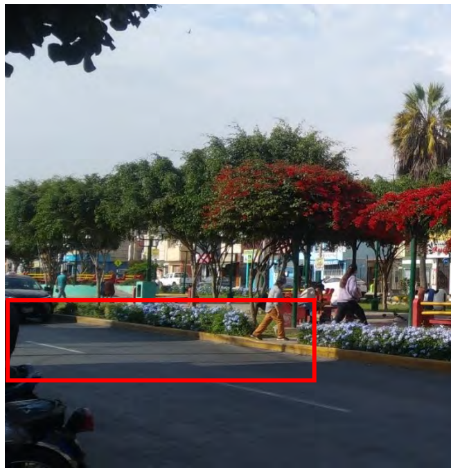
Figura 21. Cruce peatonal inseguro, sin señalización horizontal. Fuente: Propia
