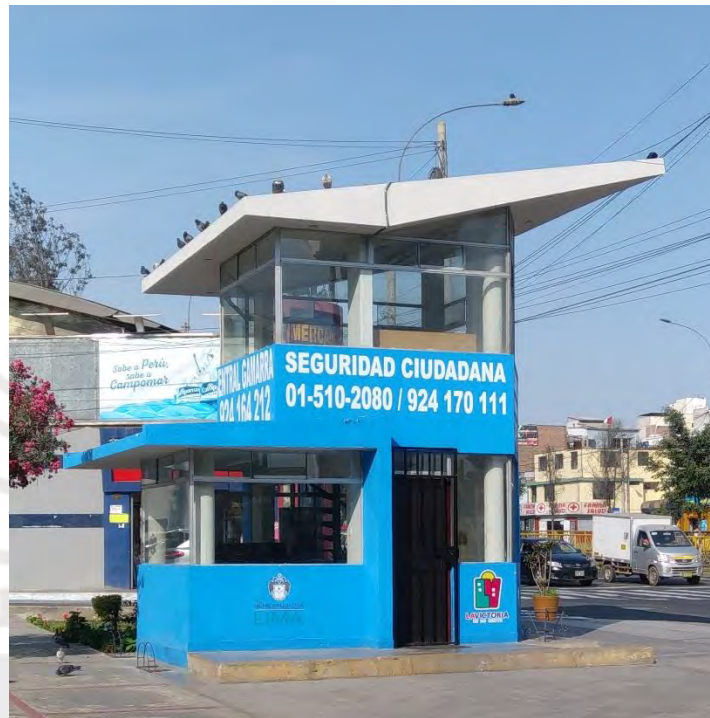
Figura 44. Puesto de auxilio rápido de la MLV. Fuente: Propia
