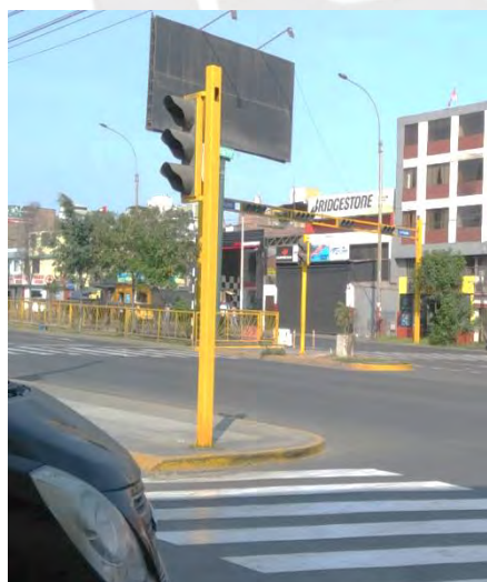
Figura 22. Semáforo en intersección con Av. Canadá. Fuente: Propia
