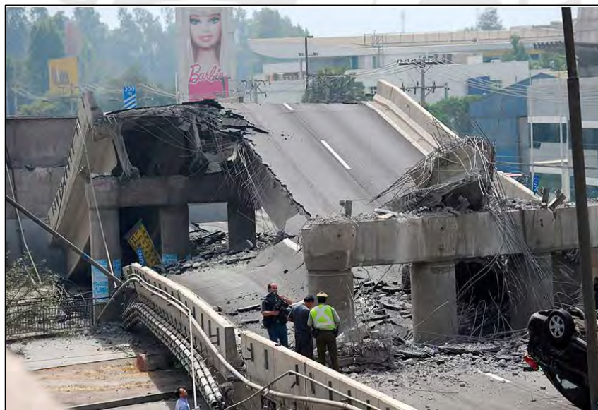
Figura 1 Colapso de viaducto en Av. Circunvalación Norte de Santiago de Chile debido al Terremoto 27 de febrero del 2010. (Fuente, El Mercurio, Chile)
