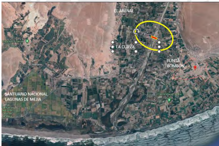
Figura 3 Vista de ubicación del puente Freyre, ubicado en Arequipa. Fuente, Google Earth
