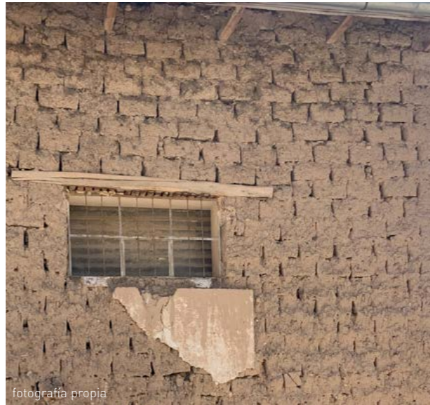
Muro de adobe en Chupuro
