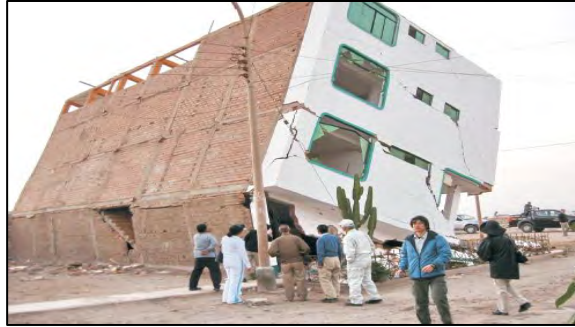
Figura 3. Viviendas de concreto destruidas Fuente: Compendio estadístico de prevención y atención de desastres 2007
