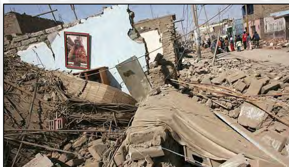
Figura 2. Viviendas destruidas por el terremoto Fuente: Perú21
