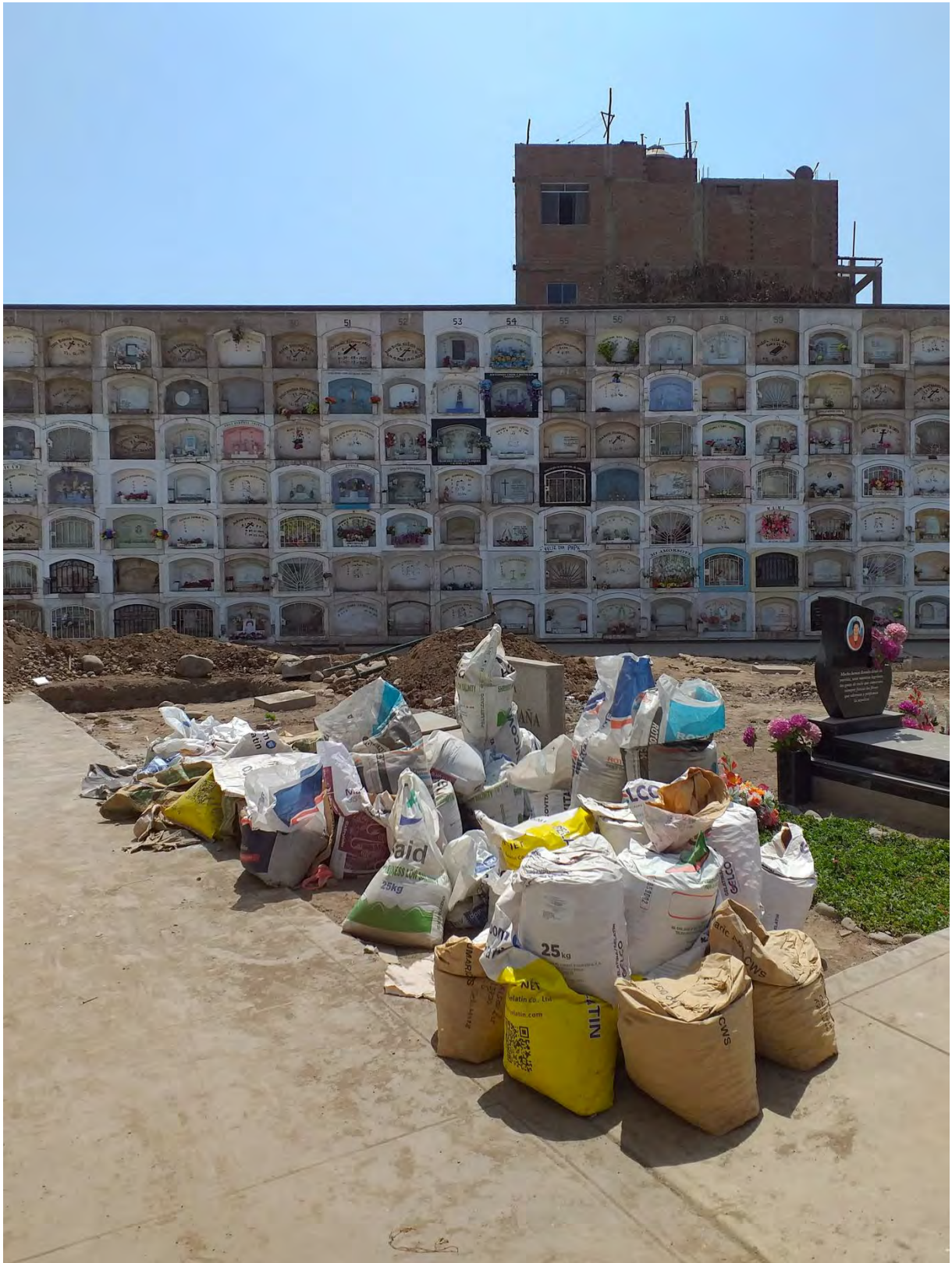
Figura 6: Interior del cementerio “El Ángel”, fotografía de situación. Proceso de construcción de 2 espacios para tumbas en jardines intermedios del cementerio, los cuales originalmente no estuvieron destinados para este uso. Fotografía: Christian Fernández Rivas, octubre 2022.
