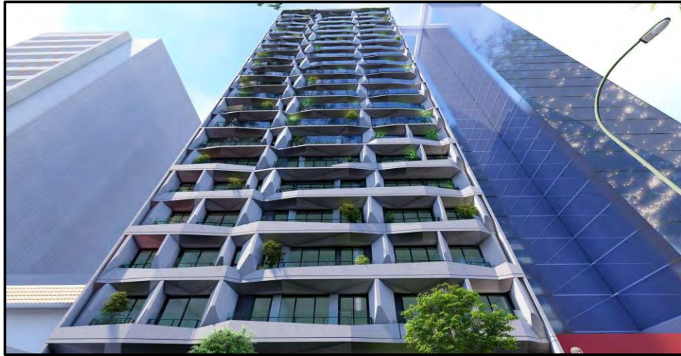
Fachada Principal del proyecto Pardo 669
