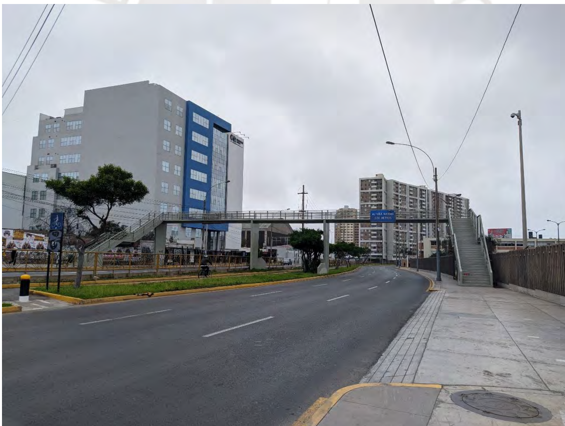
Figura 3. Puente de cruce peatonal, Av. Universitaria.
