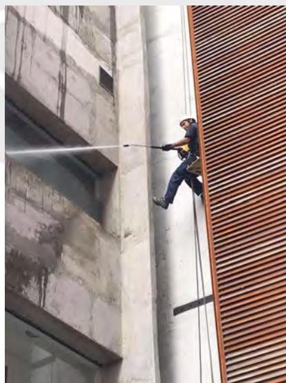
Figura 1.6: Uso de equipos de seguridad para limpieza en altura. Extraído de LIMFE, s.f.
