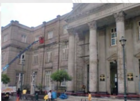
Figura 1.4: Servicios privados de hidrolavado en altura. Extraído de MANSERCOM SAC, 2023.
