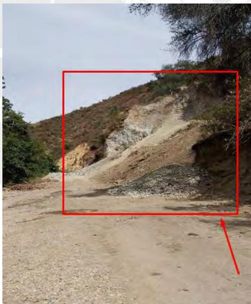
*Nota.* Se puede observar la presencia de movimiento de tierras en las progresivas 5+700 km debido al elevado talud en dichas progresivas que dificultan el libre paso, elaboración propia.
