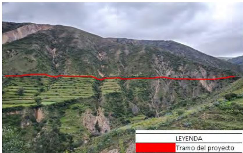
*Nota.* La línea roja por encima de la figura que está por encima de los aterrazamientos es el tramo que comprende a la progresiva km 5+500 hasta la progresiva km 5+750, que es uno de los tramos donde se observa un ángulo de inclinación mayor y, por ende, mayor peligro a la hora de ejecutar la trocha. Tomado de Eirl (2019).
