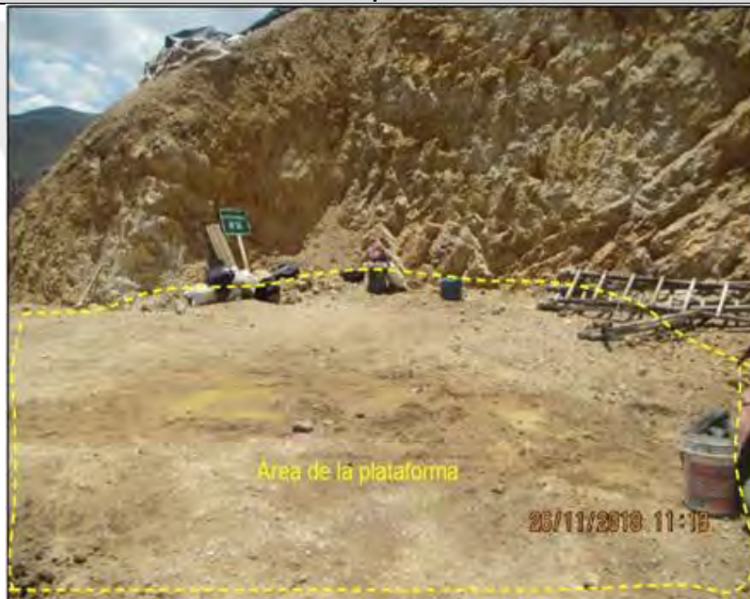
Fotografía N° 7: Hecho detectado N° 2. Vista panorámica de la plataforma de perforación P-18, ubicada en las coordenadas UTM WGS 84 (Zona 18): 501201 E, 8601530 N y 3921 m.s.n.m.
