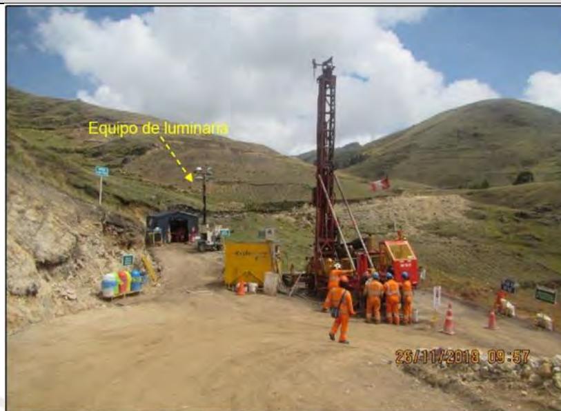
Fotografía N° 2: Hecho detectado N° 1. Vista panorámica de la Plataforma de Perforación P-19, ubicada en las coordenadas UTM WGS 84 (Zona 18): 501081 E, 8601737 N y 3925 m.s.n.m.
