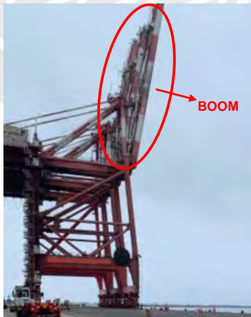
Gráfico 20: Grúa pórtico con el boom levantado
