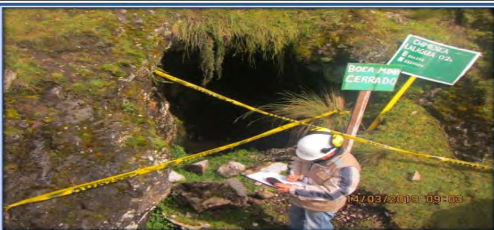
Fotografía N° 6: Se observa abierto la entrada de la bocamina Lalaquia 2, con material acumulado en la entrada, vegetación en su ingreso y presenta agua acumulado en su interior
