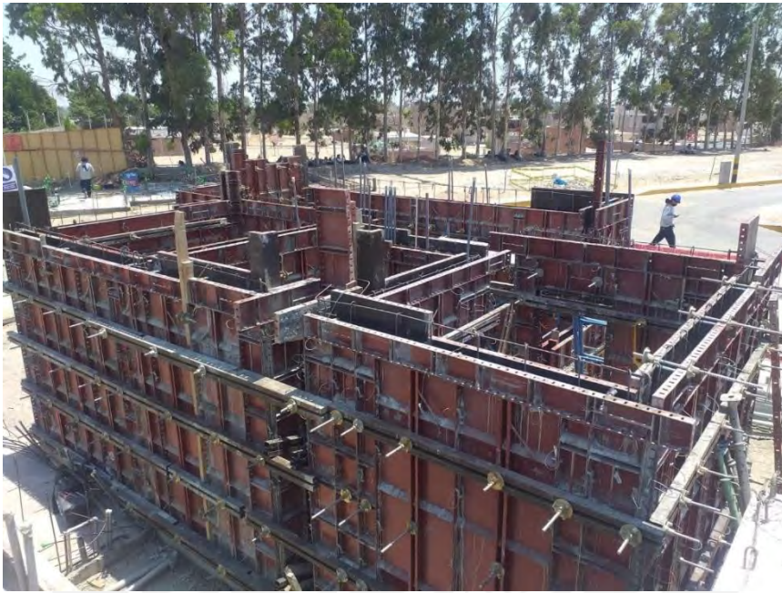
Figura 19: Encofrado modular caso de estudio 1
