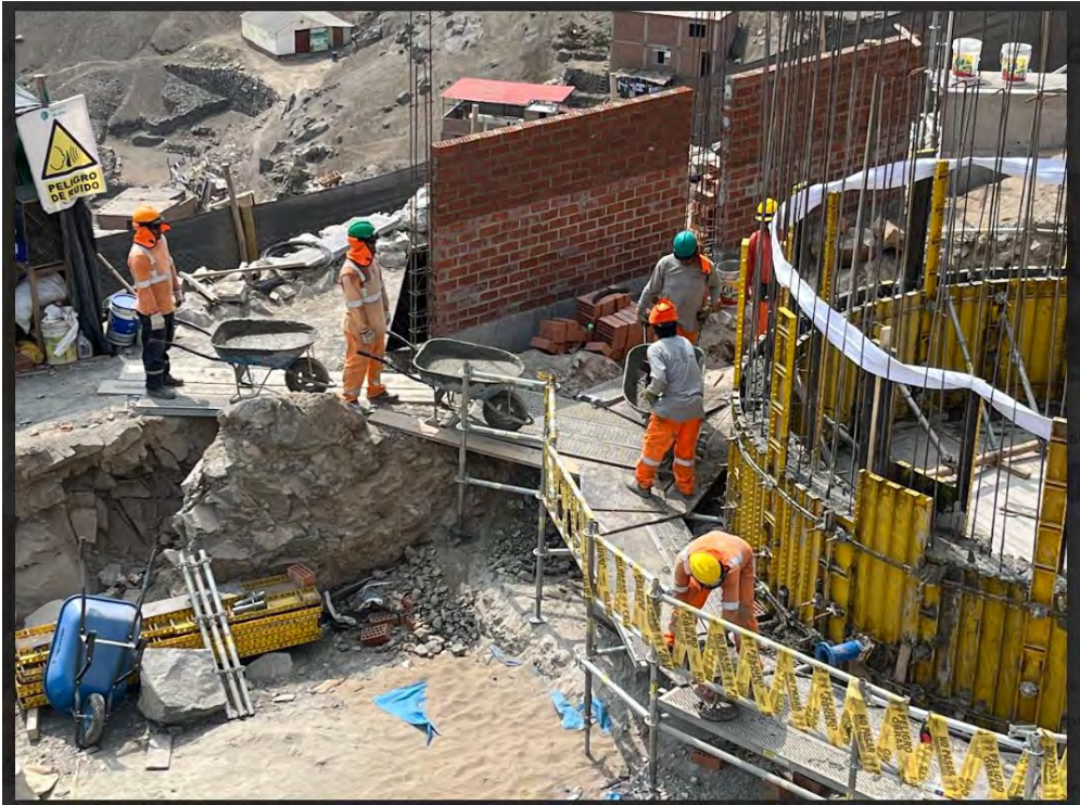
Foto 1: Cuello de botella formado por carretillas con concreto (1er Muestreo – 13/04/23)
