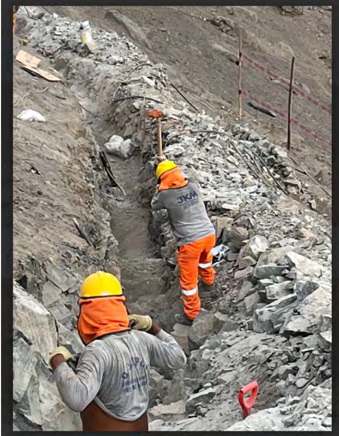
Foto 7: Excavación manual de línea de aducción con comba (2do Muestreo – 14/04/23)
