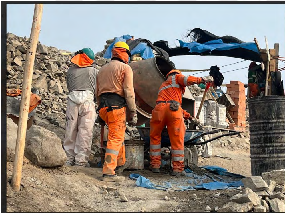
Foto 2: Mezcladora tipo trompo para fabricar concreto (1er Muestreo – 13/04/23)
