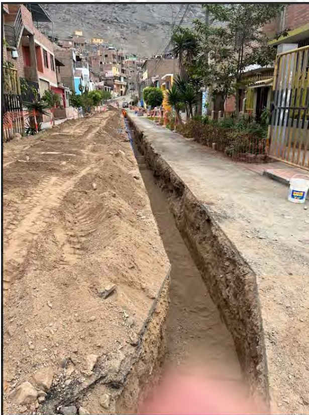
Foto 10. Tramo de Troncal CD – 04 excavada (1er Muestreo - 19/04/23)
