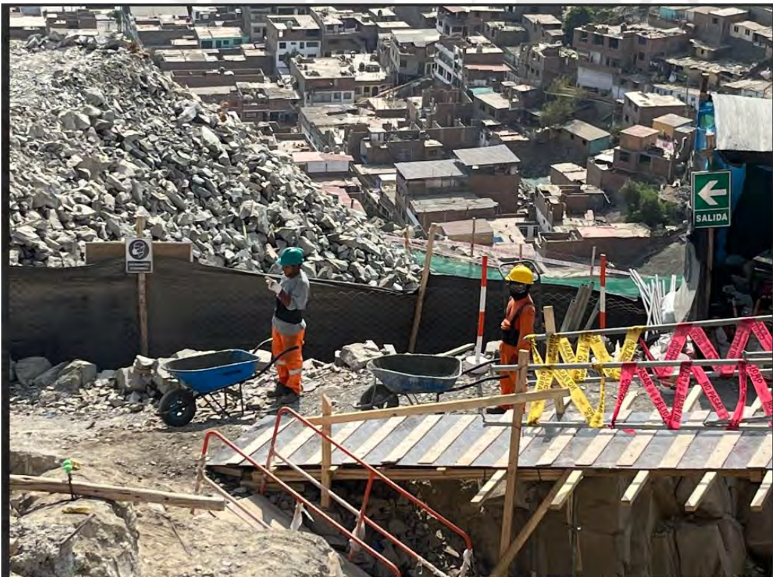
Foto 4: Esperas de las carretillas “buggy” para abastecer concreto en mezcladora (2do Muestreo – 20/04/23)
