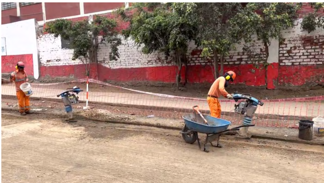
Foto 17: Humedecimiento y compactación de zanja Troncal CD – 04 (1er Muestreo – 17/04/23)
