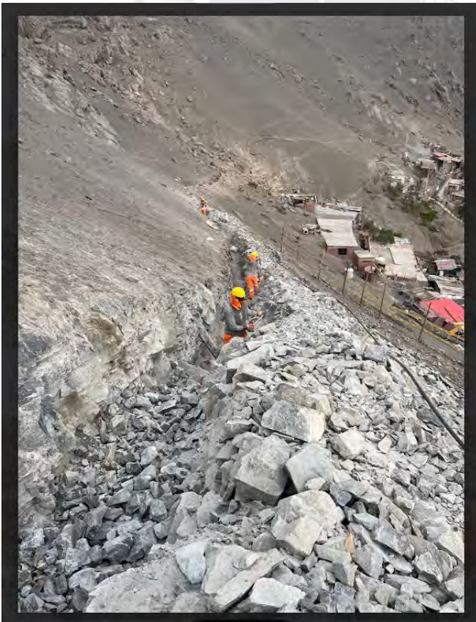
Foto 8: Cuadrilla excavando a lo largo de la zanja (2do Muestreo - 14/04/23)
