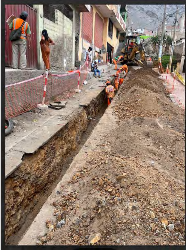
Foto 9: Excavación manual y con maquinaria de Troncal CD – 04 (1er Muestreo - 19/04/23)
