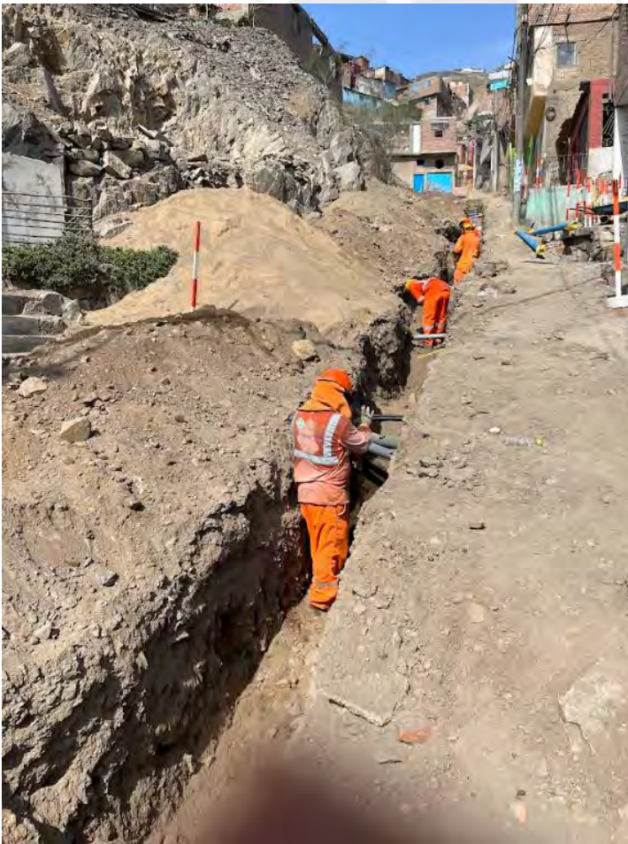
Foto 12: Presencia de interferencias en excavación de Troncal CD – 05 (2do Muestreo – 21/04/23)
