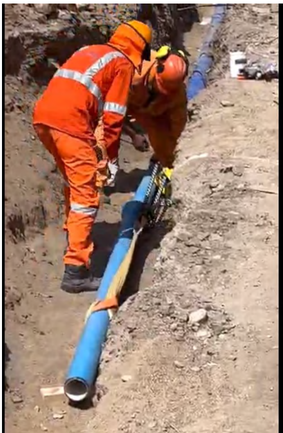
Foto 15: Colocación de tubería de hierro dúctil en zanja (2do Muestreo – 24/04/23)
