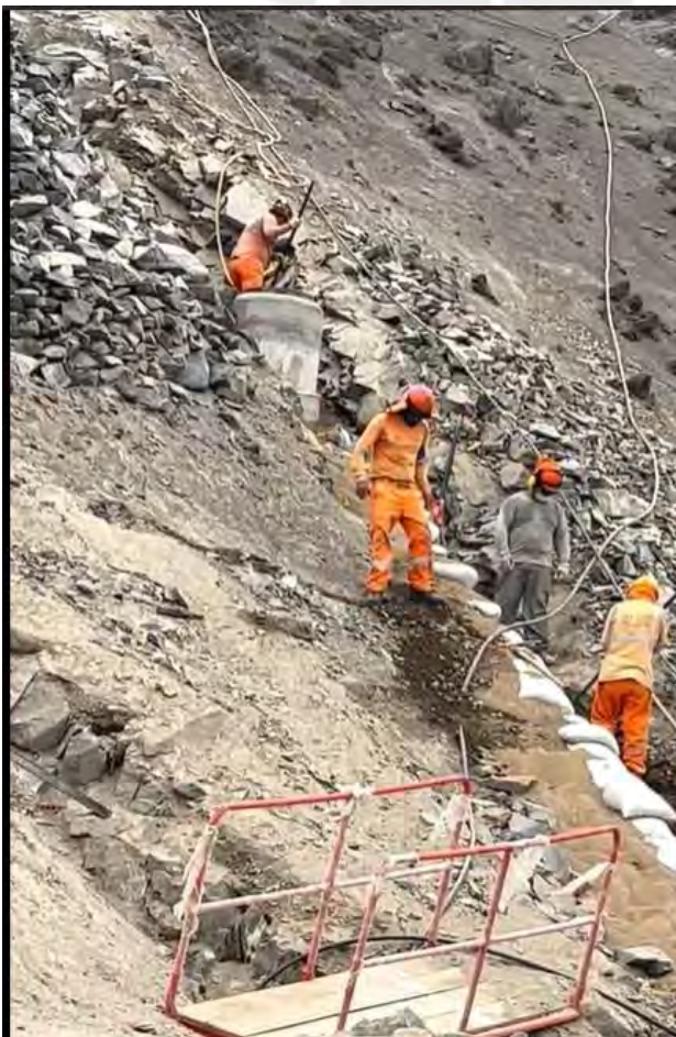
Foto 6: Cuadrilla excavando línea de aducción de reservorio (1er Muestreo – 12/04/23)
