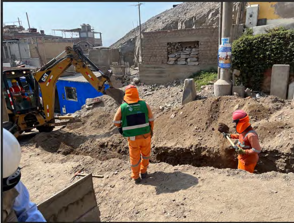
Foto 11: Excavación de Troncal CD – 05 (2do Muestreo – 21/04/23)
