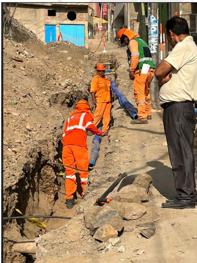
Foto 16: Avance progresivo en el tendido de tubería (2do Muestreo – 24/04/23)
