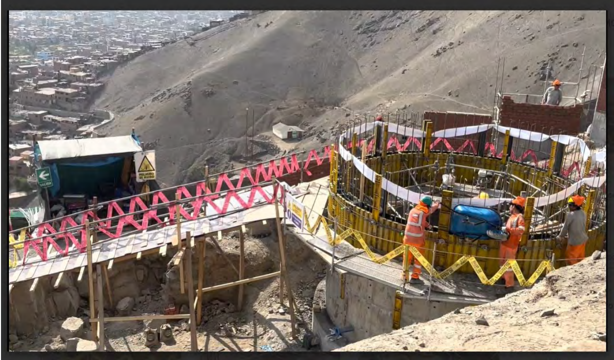
Foto 3: Vaciado mediante carretilla “buggy” en 3er anillo de fuste (2do Muestreo – 20/04/23)
