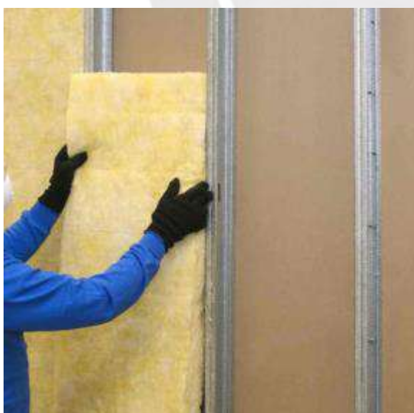
Figura 4 Colocación de fibra de vidrio
